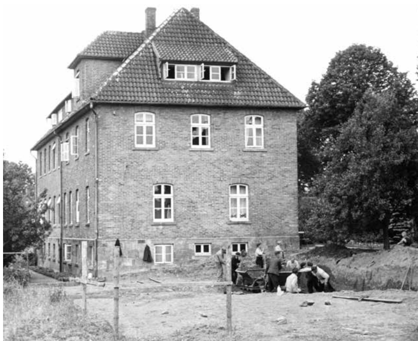
Abb. 12: Beginn der Erdarbeiten am 26. Mai 1952
