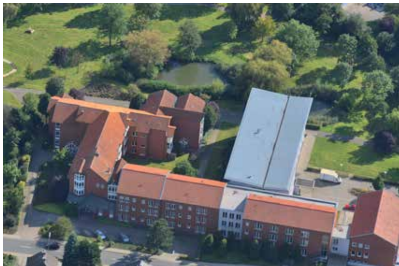
Abb. 41: Luftaufnahme aus Richtung Norden (Natruper Straße)
