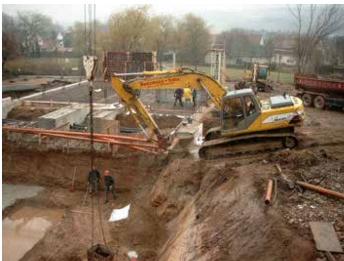
Abb. 36: Erd- und Gründungsarbeiten
