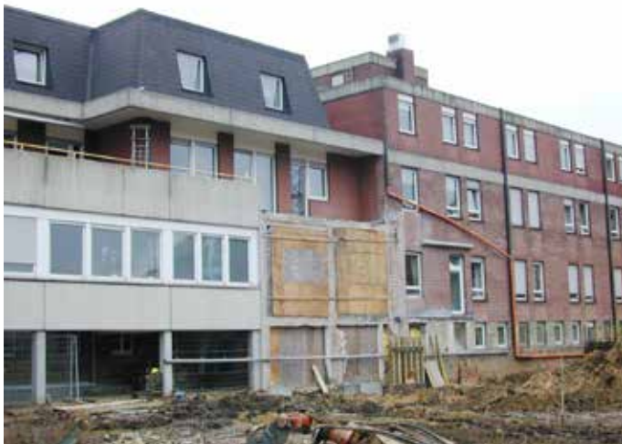
Abb. 35: Südseite nach Abbruch der Kapelle Ende 2002
