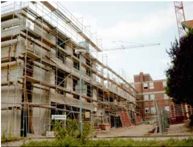
Abb. 39: Süd-Ost-Ansicht des Rohbaus
