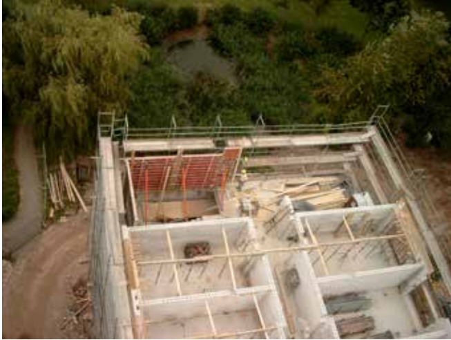
Abb. 38: Blick vom Kran auf den späteren Südbalkon
