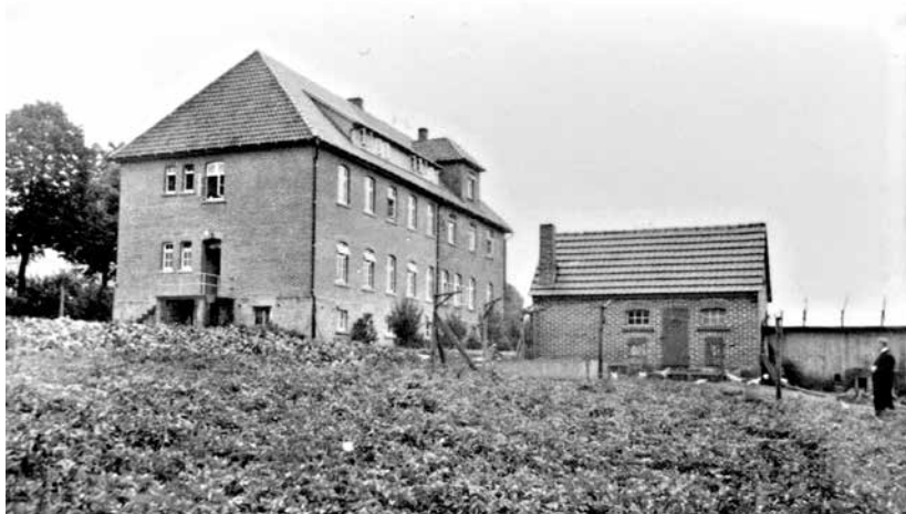
Abb. 21: Altes Wirtschaftsgebäude an der Westseite, 1965 abgerissen
