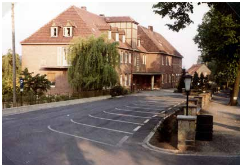
Abb. 18: Ansicht 1959 mit Fahrstuhlschacht und Parkplatz
